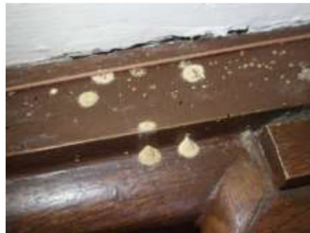
Hoopjes boormeel van kleine houtworm.
