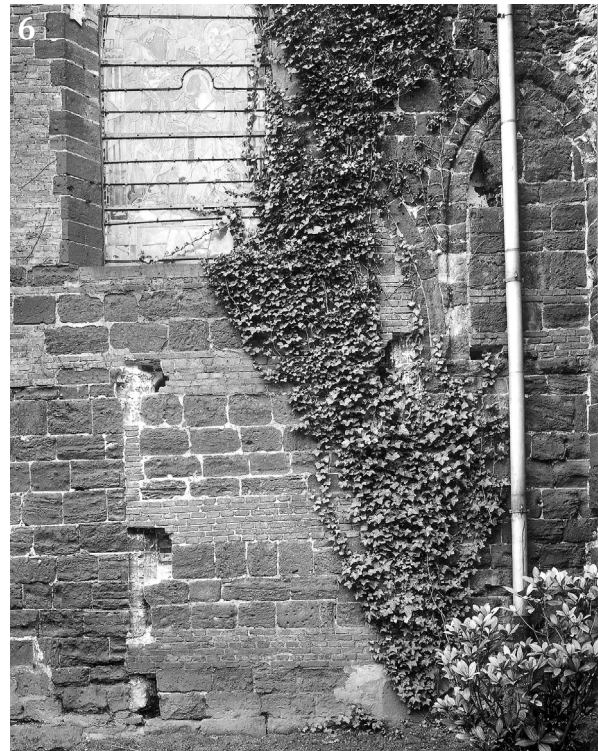
Afbeelding 5. Dichtgemetseld portaal (vermoedelijk tussen 1300 en 1400) in de noordelijke zijbeuk. Rechts toont zich de brede steunbeer. Foto uit 1943. Bron: [© KIK-IRPA, Brussels (Belgium), cliché A056575].
